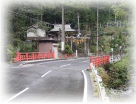
大岳橋 釣り場区間はこの橋の手前までです。
